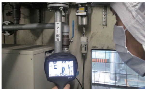
音響カメラを使用したエアリーク点検の様子
