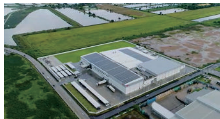
太陽光発電設備 (タイデルマール社)
