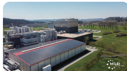
ミライ社の太陽光発電設備
