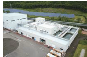
磯分内工場の排水処理設備
