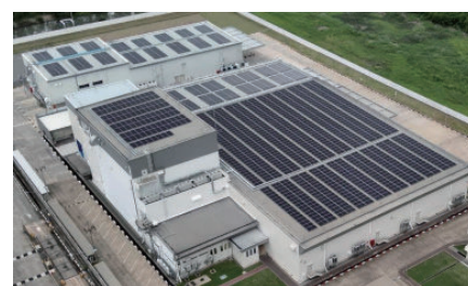
太陽光発電設備を導入した NIPPN(Thailand)CO.,Ltd.
