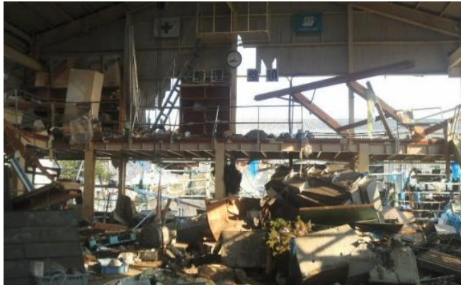
震災津波で壊滅状態（第一工場）
