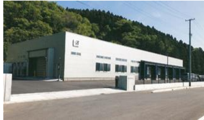
新社屋・工場棟（R元年5月竣工）
